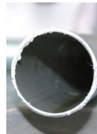
Esempio di rimozione del calcare
