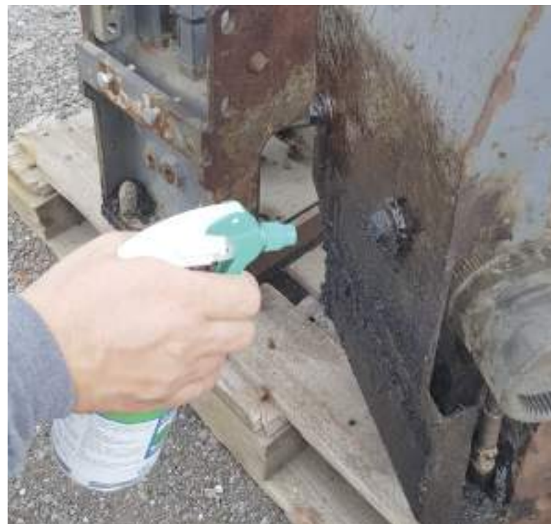
Rimozione del bitume con GS 200
